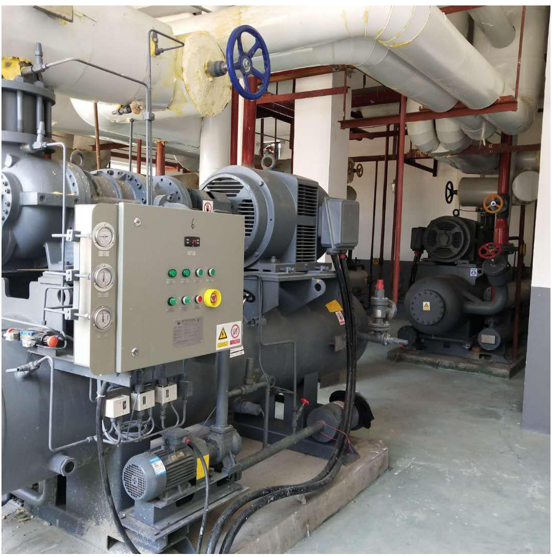
制冷机减振措施照片
